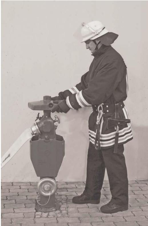
Mit dem Überflurhydrantenschlüssel wird durch Linksdrehen des Dreikants die Sperre des Fallmantels gelöst. Dann werden die oberen Ventilabgänge frei.
