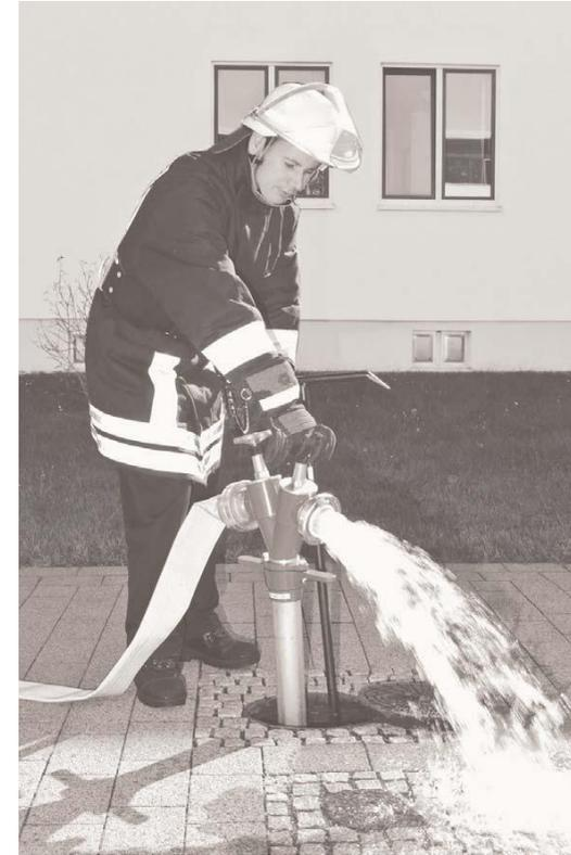
Ein Abgang am Standrohr wird geöffnet.
