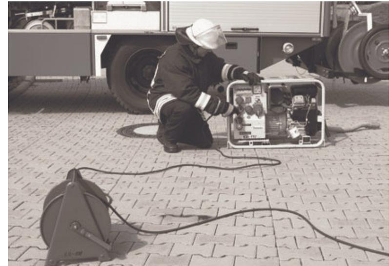
Der Maschinist nimmt den Stromerzeuger in Betrieb, zieht die Zuleitung mit Stecker von der Hilfstrommel ab und schließt, nachdem der Verbraucher angeschlossen und die gesamte elektrische Leitung (Stromversorgung) aufgebaut ist, den Stecker an den Stromerzeuger an.
