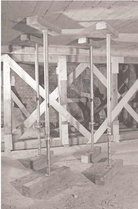
Die erforderliche Anzahl der Stützen ist von deren Tragfähigkeit und der zu stützenden Last sowie der Stützhöhe abhängig.
